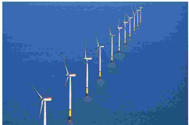
Il ministero della Transizione ecologica sta provando a promuovere gli impianti eolici offshore flottanti
