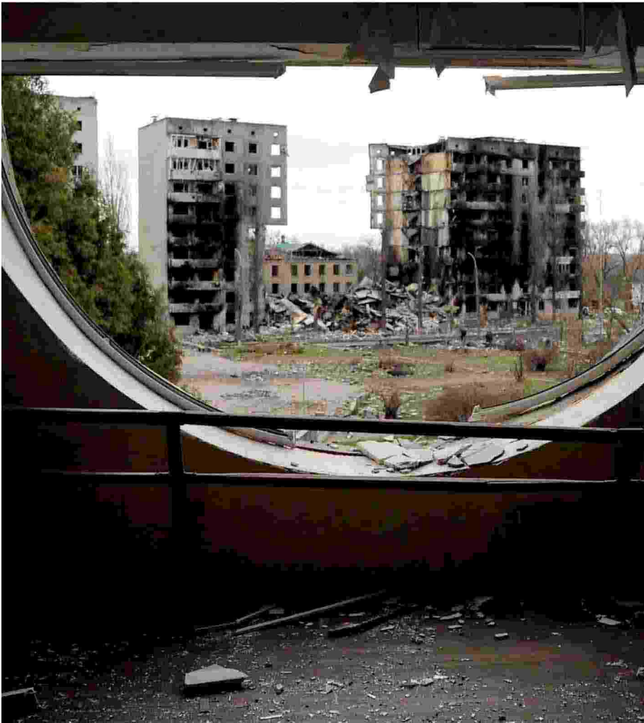
Palazzi distrutti a Borodyanka, dopo la ritirata dell'esercito russo, che si sta concentrando sul fronte sudest FOTO AP
